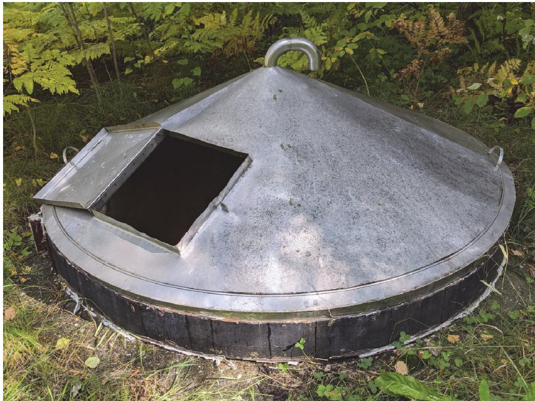
Photo 1 : Aperçu du regard en béton qui relie les drains - 2020-09-24
